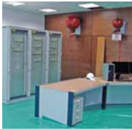
Рис. 4. Внешний вид операторной
