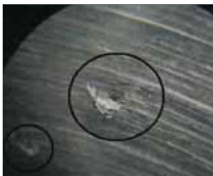
Дефект № 7 (шлаковое включение)
